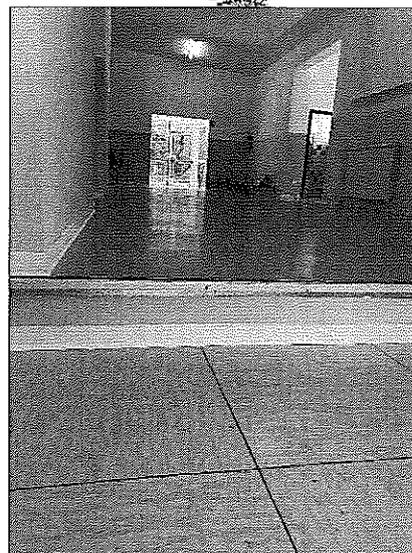
**CRITICITA' RILEVATA: Presenza di giunzioni metalliche disconnesse tra le pavimentazioni e dislivello tra differenti tipologie di pavimentazione di fronte alle sezioni**
